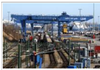
Intermodal ECL KV Terminal im Lübecker Hafen
