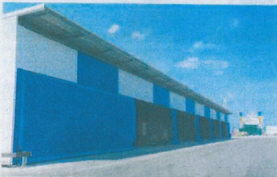
Die neue Papier-Vorstellhalle am Warnowkai geht in Betrieb.
